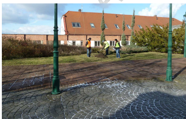
Obr. č. 6: Fotografie pořízená v rámci průzkumných prací. Provádění kopané sondy do střešní skladby – vegetační souvrství.
