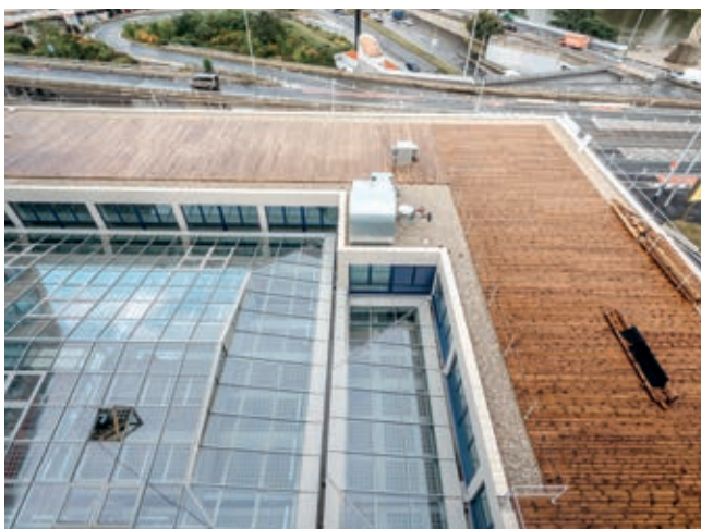
Pohled na zastřešení objektu
