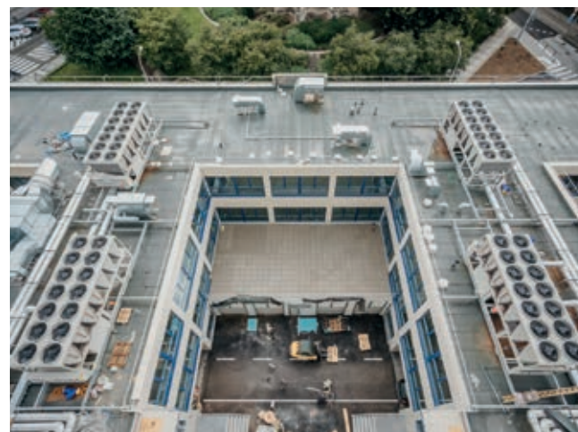
Atrium po rekonstrukci
