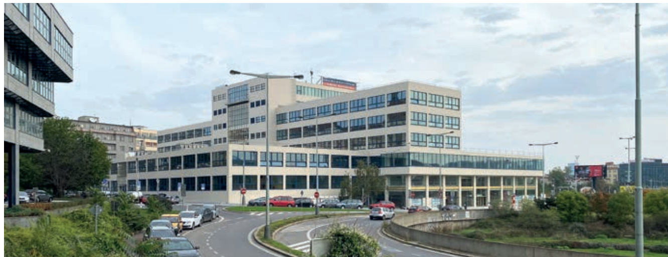
Jihozápadní pohled na objekt Bubenská
