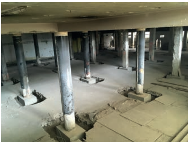
Technologická opatření pro zesílení konstrukcí
