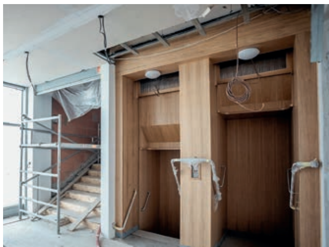
Výtahy po rekonstrukci
