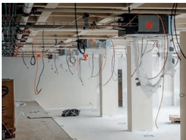
Nové rozvody elektroinstalací
