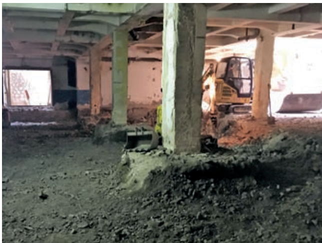
Původní skeletové konstrukce
