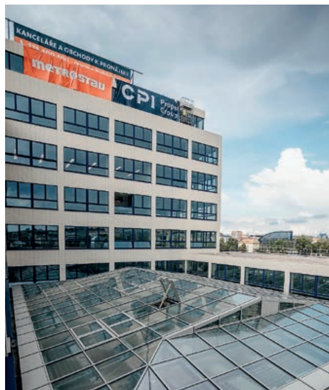
Fasáda a zastřešení budovy Elektrických podniků
