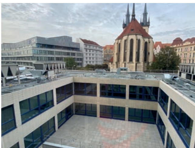
Nahoře střecha C, dole střecha nad vjezdovým domkem
